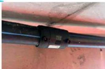
Photos après remise en eau
